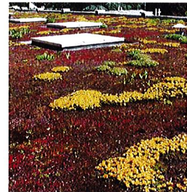
Végétation extensive en toiture
