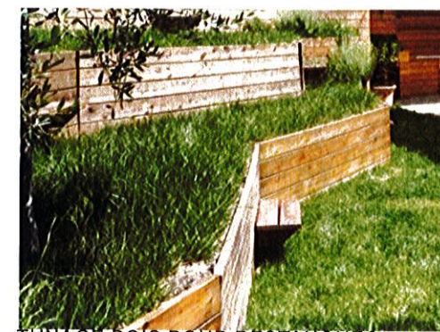
TUNAGE BOIS POUR RESTANQUES VÉGÉTALISÉES SUR LES TALUS
